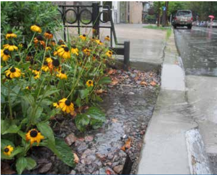
Right of way bioswales, New York
